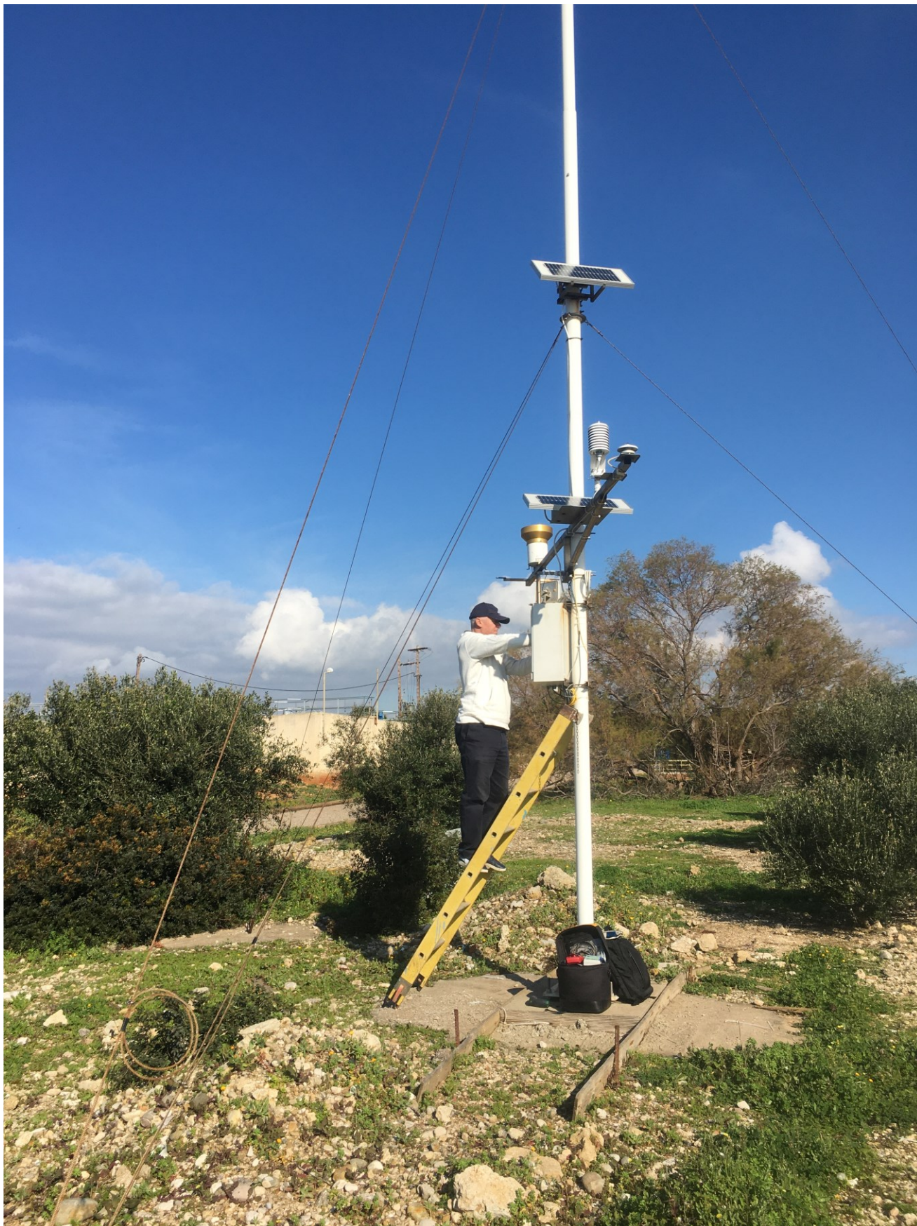
Εικόνα 1.2-2: Απο τις τεχνικές εργασίες στον σταθμό KTL-1 στις 4/1/2022.
