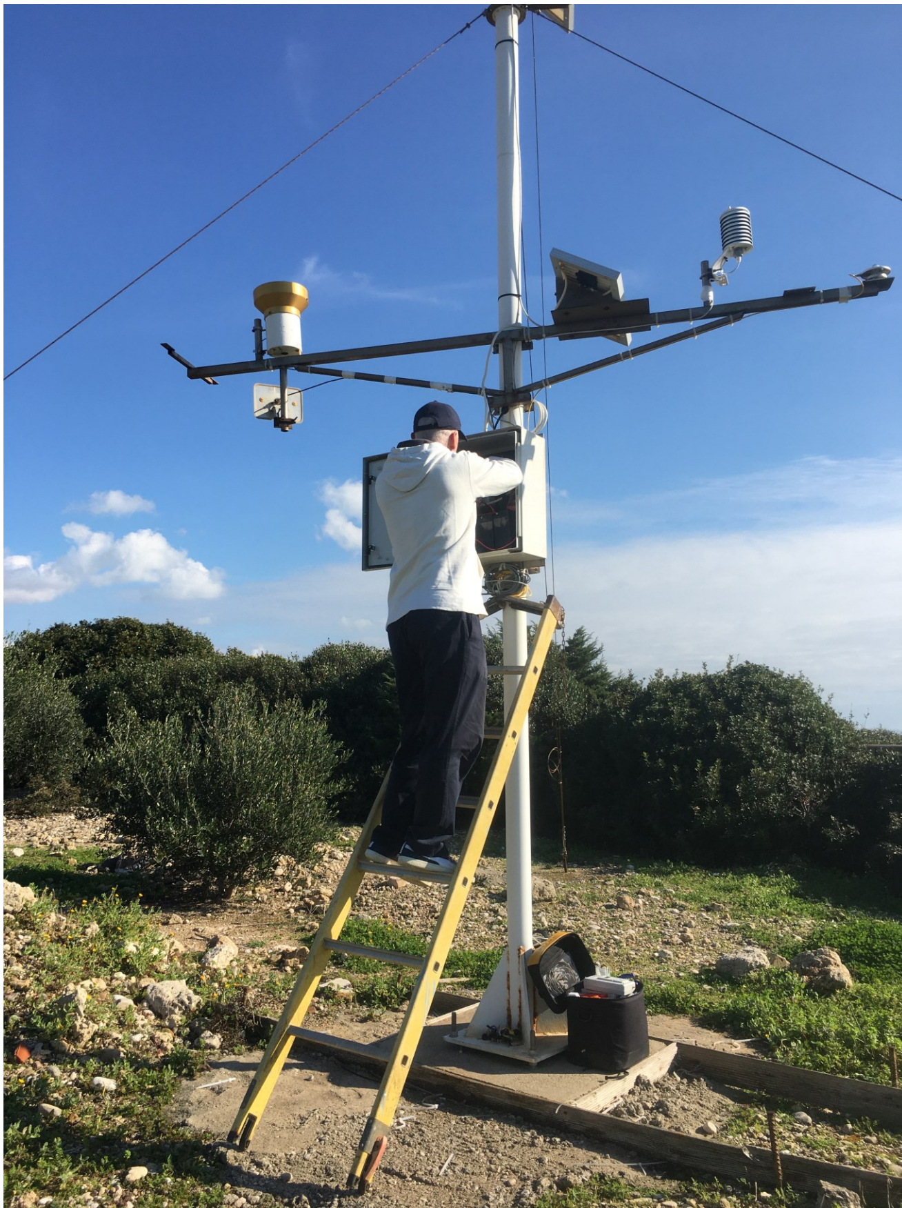
Εικόνα 1.2-4: Απο τις τεχνικές εργασίες στον σταθμό KTL-1 στις 4/1/2022.
