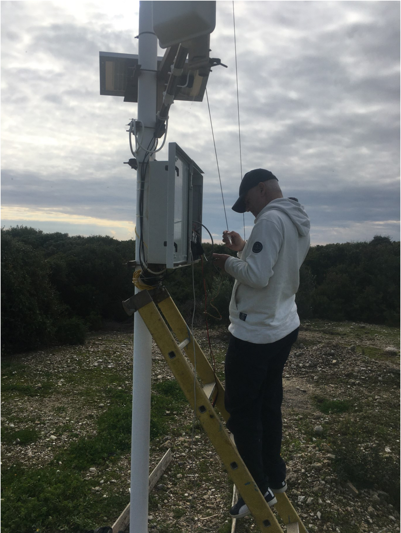
Εικόνα 1.2-5: Απο τις τεχνικές εργασίες στον σταθμό KTL-1 στις 4/1/2022.
