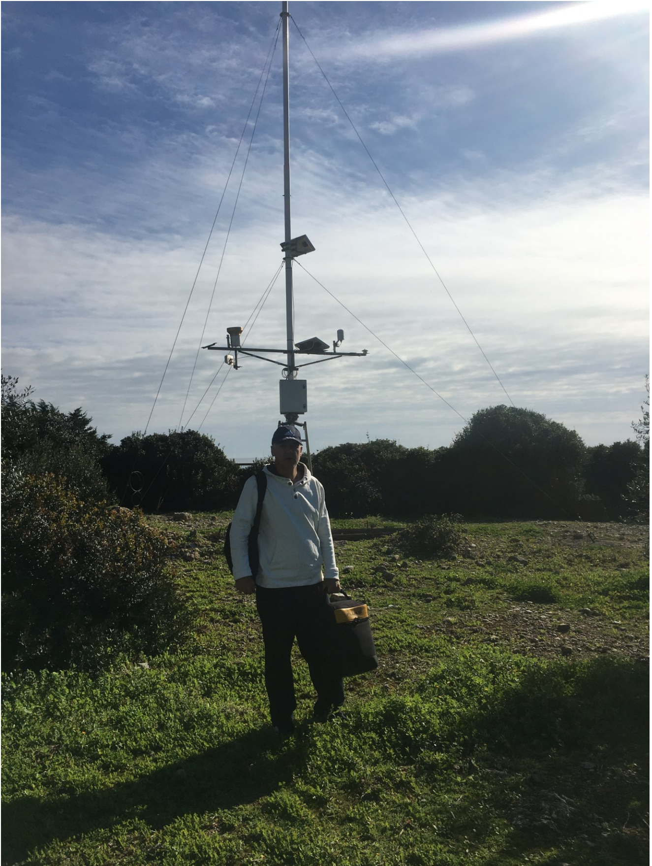
Εικόνα 1.2-1: Απο τις τεχνικές εργασίες στον σταθμό KTL-1 στις 4/1/2022.
